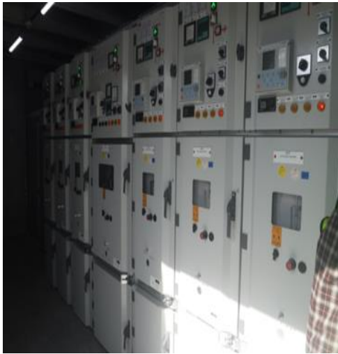
11Kva switch gear
